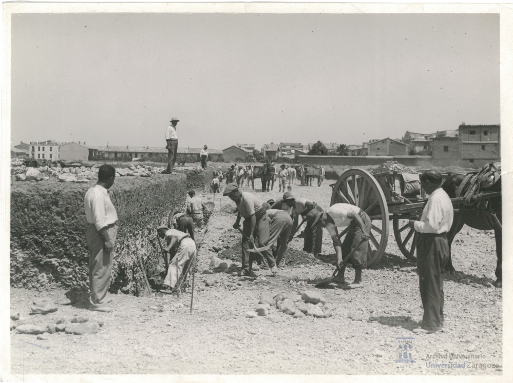
Inicio de obras en la Ciudad Universitaria del Campus San Francisco 1935. Fotografía de Marín Chivite. Archivo de la Universidad de Zaragoza
