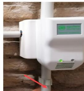
En 2021 se puso de manifiesto un grave problema con la alarma de detección de humedad, ya que no existía conexión entre el riesgo de agua y humedad y la activación de la alarma y protocolo de actuación. Tras estudiar posibles soluciones, se optó por el cableado de sensor de inundación a expansor existente y reconfiguración de zonas en el Archivo Histórico. Posteriormente, se generó un protocolo interno para Seguridad.
